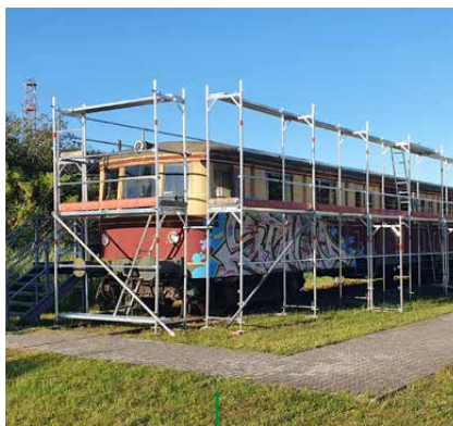
Restaurierung der Peenemünder Werkbahn
