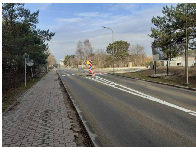
Vom Tunnel kommend kann man an dieser Stelle in Zukunft auf eine neue Zufahrtstraße Richtung Stadtzentrum am Alten Hafen einbiegen.
