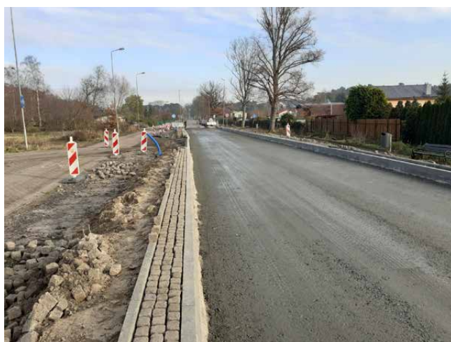
Im Bereich der früheren Abfertigungsanlage ist die Straße von Garz/ Zirchow teilweise fertig
